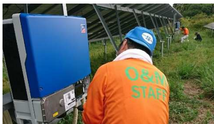
分散型PCSの開閉作業
