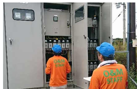
キュービクルの点検
